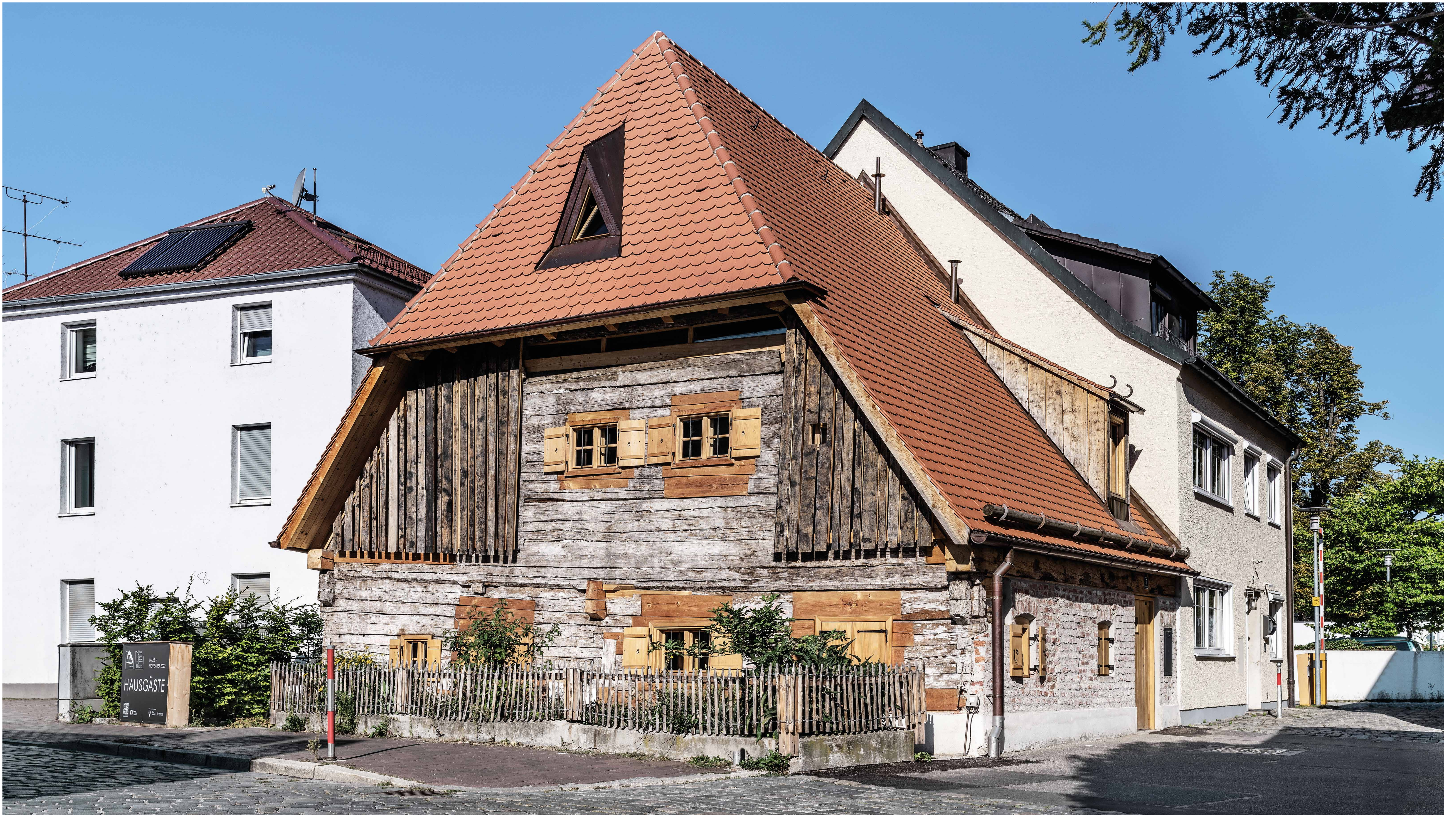
Ansicht Wagnergasse © Peter Litvai
