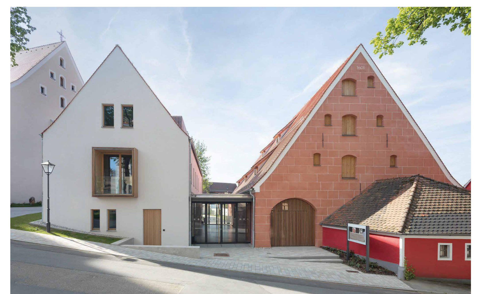
Ansicht Nord nach der Sanierung © Erich Spahn
