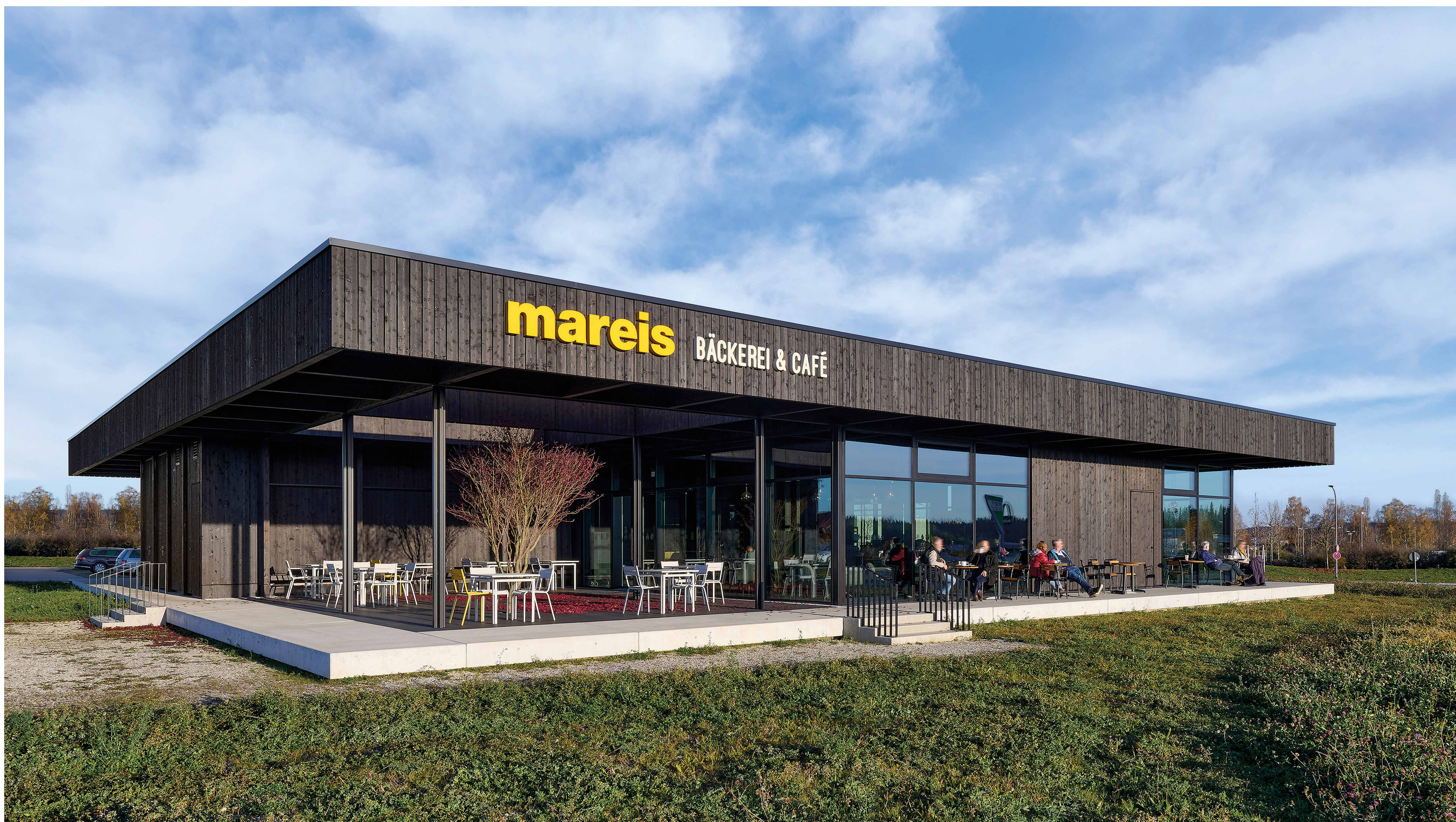
Ansicht West - Terrasse © Rolf Sturm
