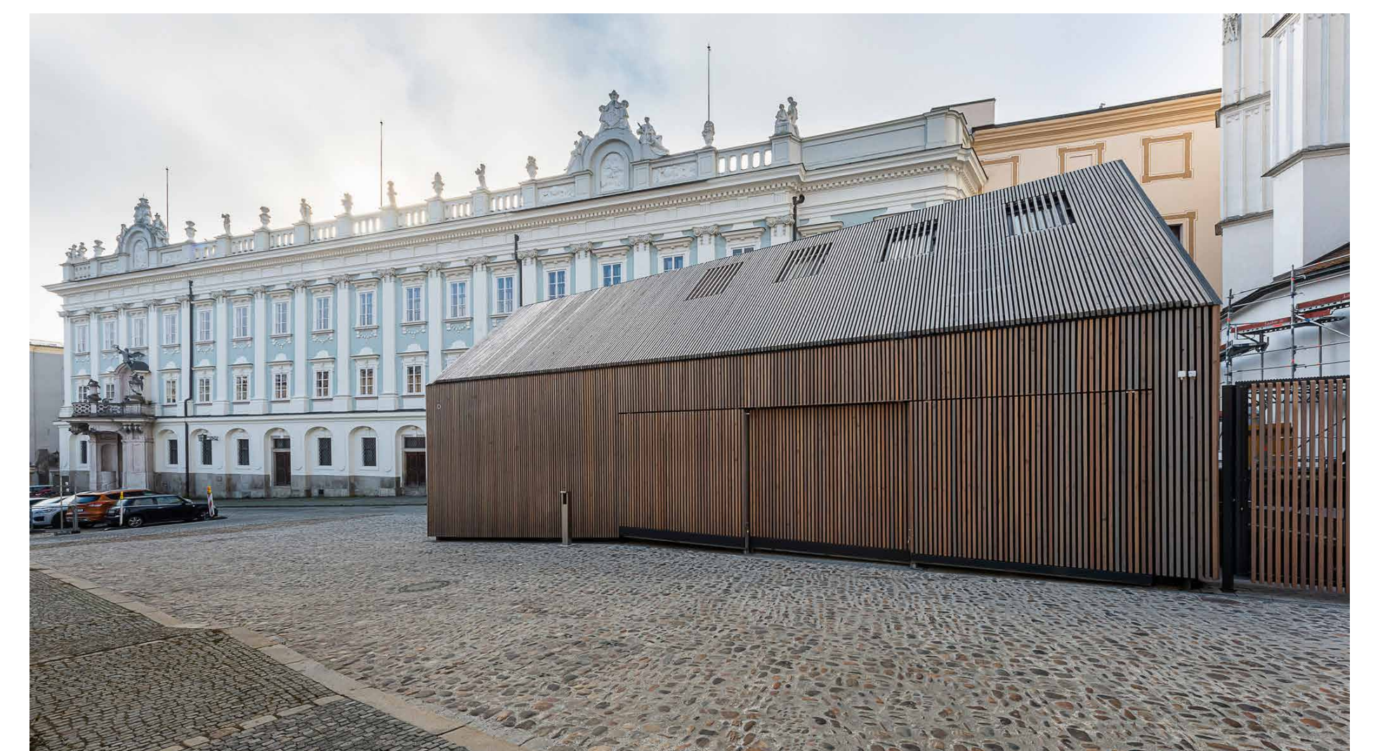
Holzkleid mit integrierten Öffnungselementen © Christian Böhm
