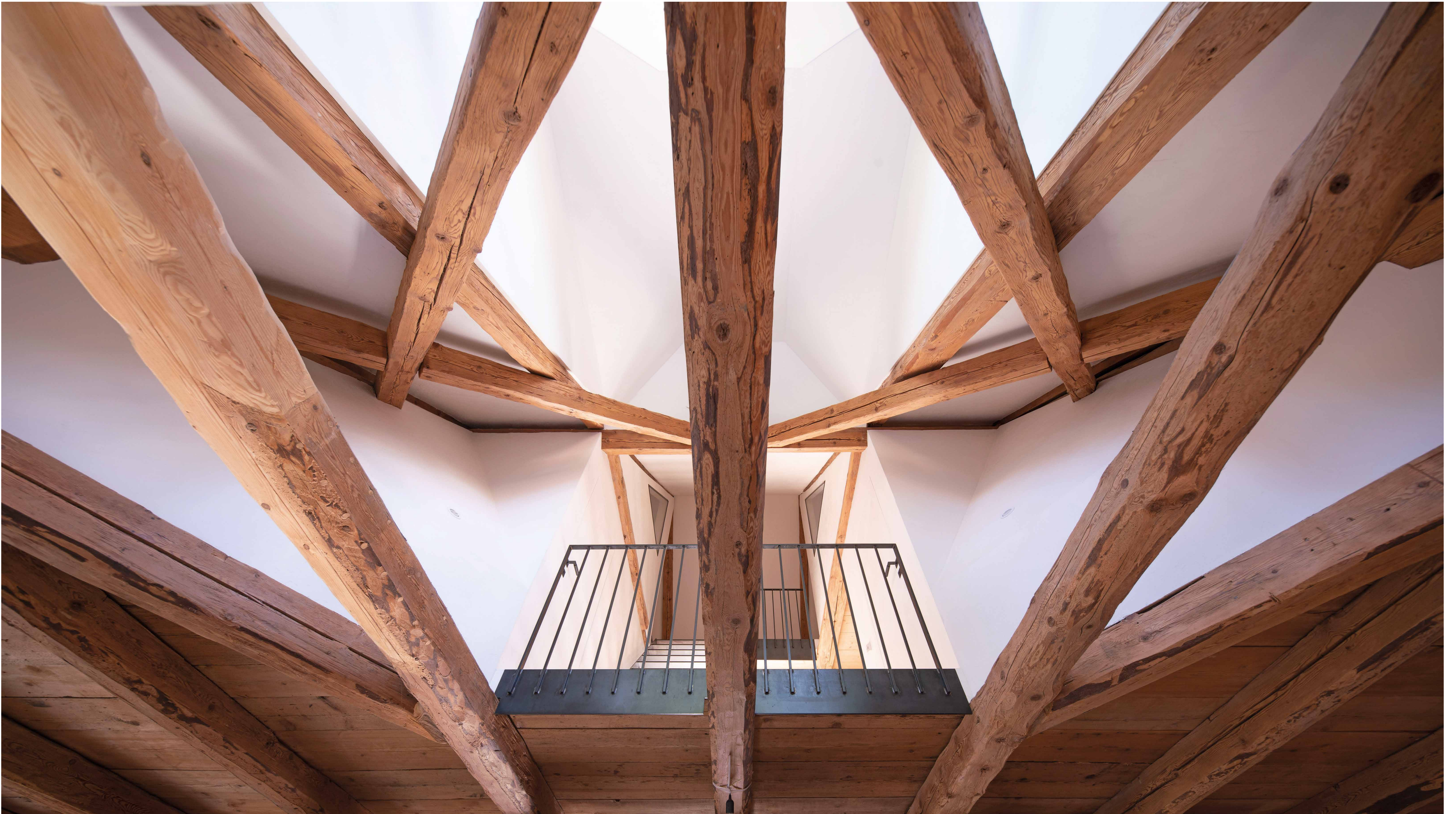
Blick in den Dachstuhl © Herbert Stolz
