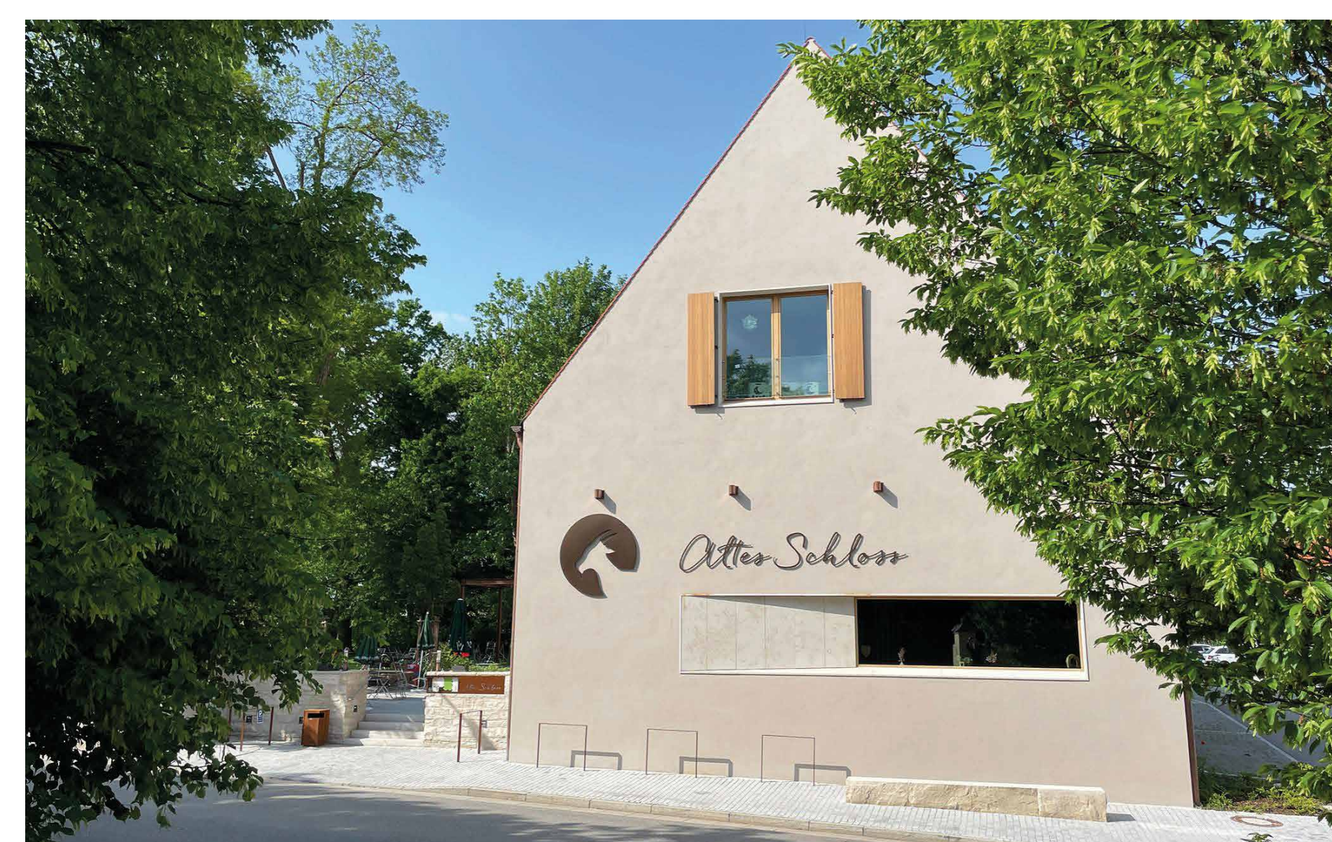
Südfassade © Gebauer Wegerer Wittmann Architekten
