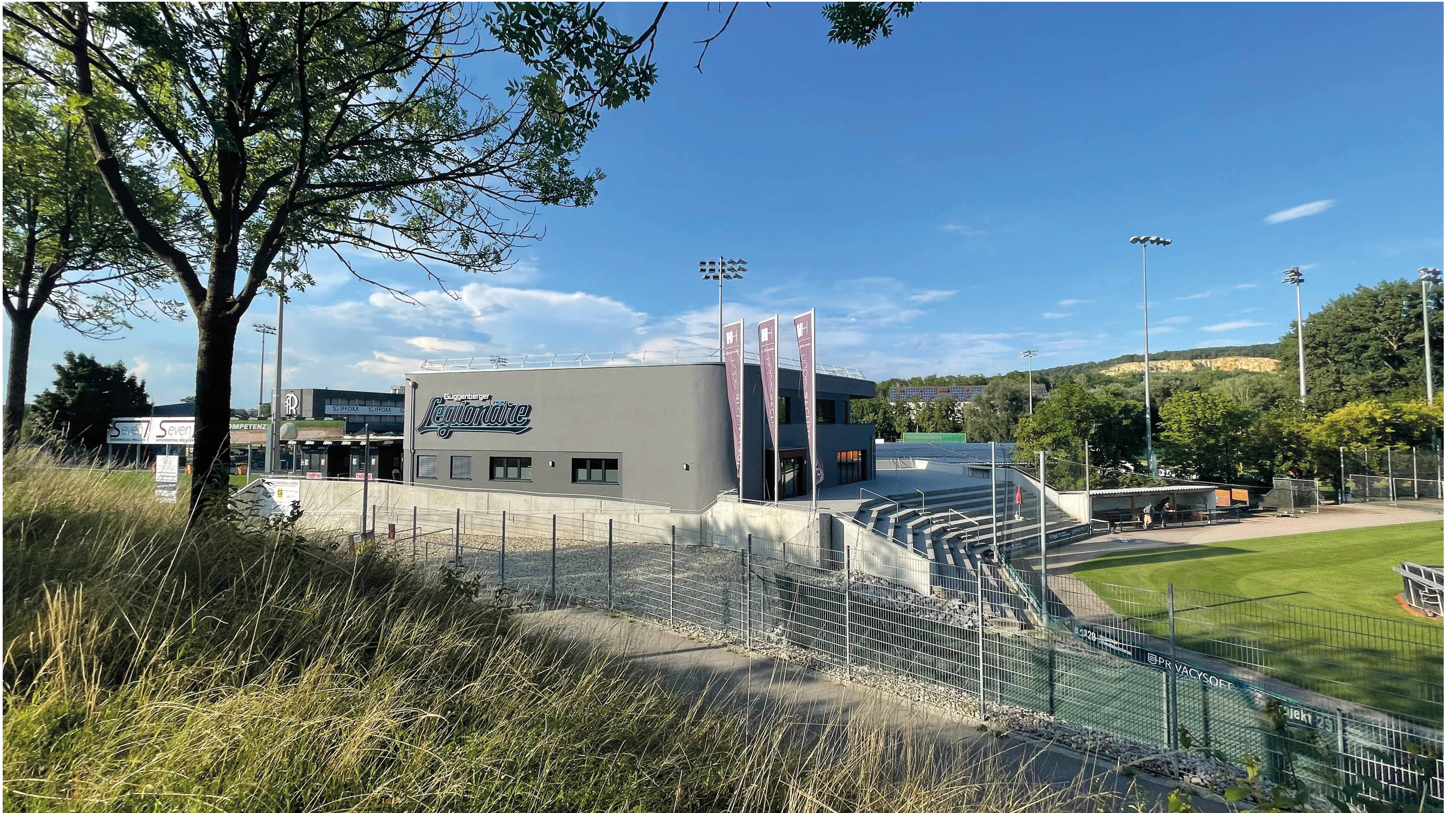
Süd-Ost Ansicht und Zugangsbereich für Zuschauer © Huber Architekten
