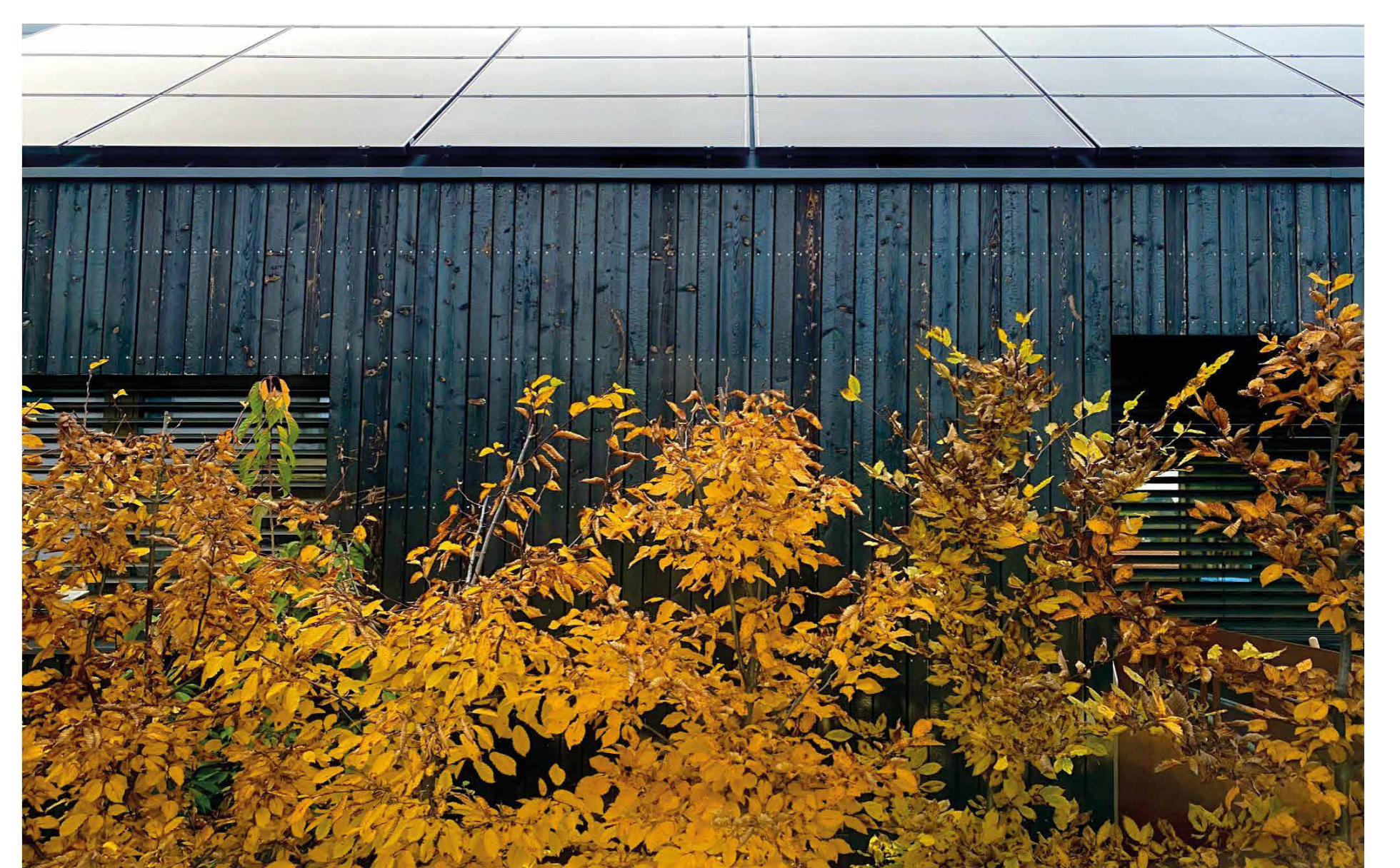
Photovoltaik - Zugang Bergseite © F.D. Beer
